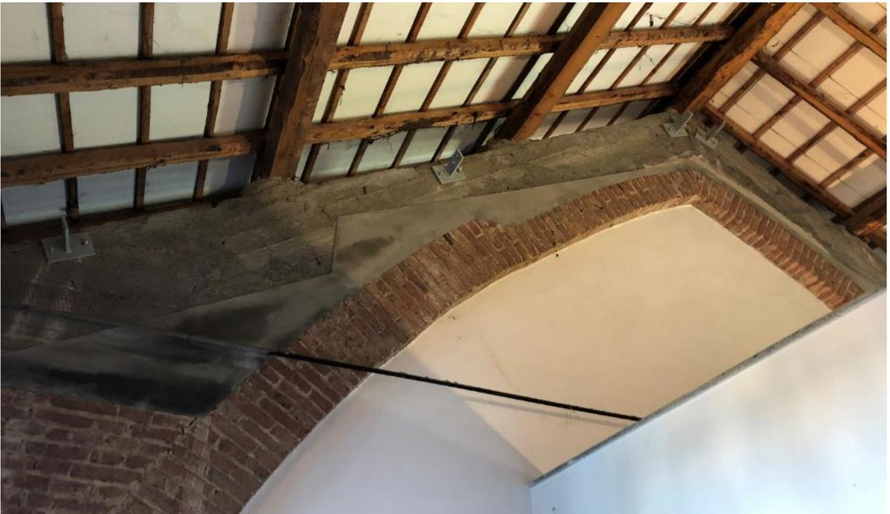
*Fase di posa delle membrature metalliche di sostegno del controsoffitto*
